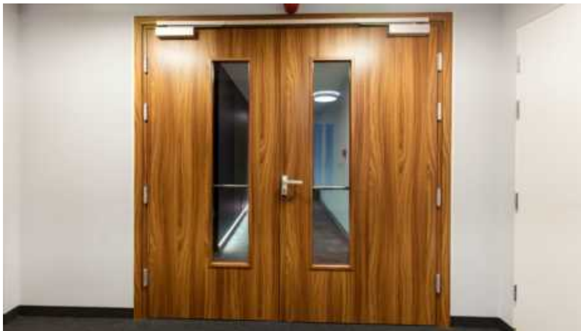
drzwi przeciwpożarowe FR EI30, ościeżnica stała drewniana
