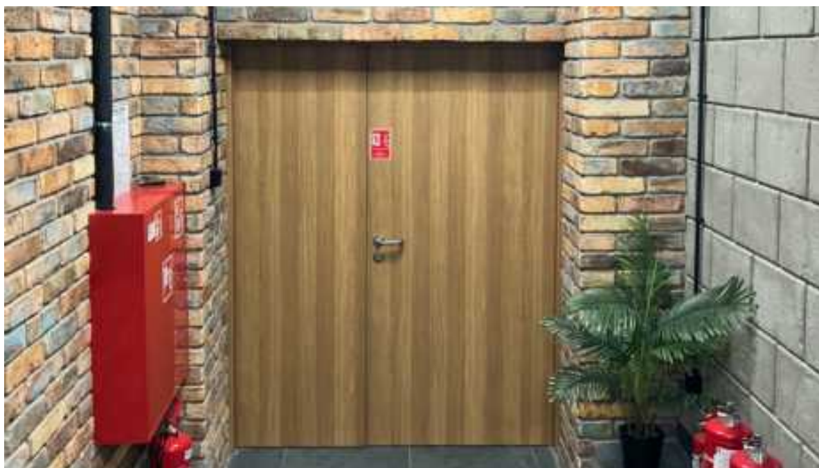
drzwi przeciwpożarowe FR EI30, ościeżnica stała drewniana
