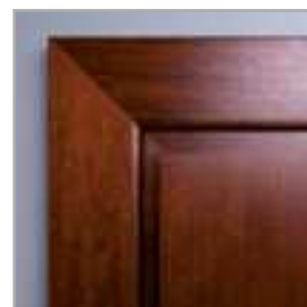
łączenie opasek pod kątem 45°
