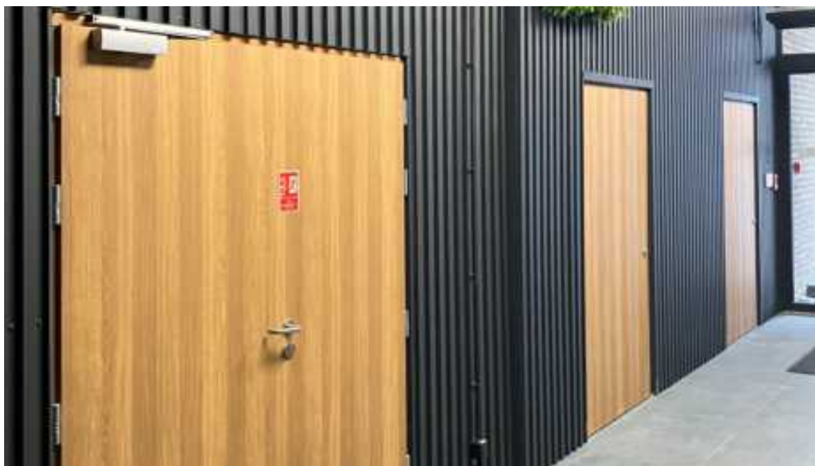
drzwi EI30 PLUS dwuskrzydłowe, ościeżnica regulowana drewniana
